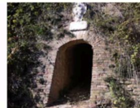
3. Vista apertura sulle mura per lo scolo delle acque
